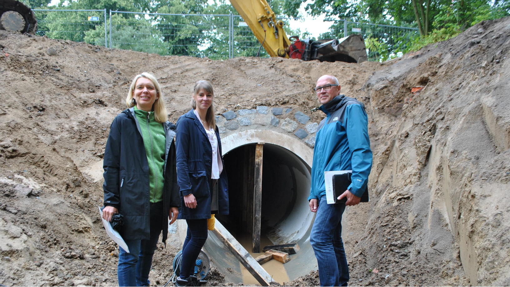
Ottertunnel Groß Thurow
