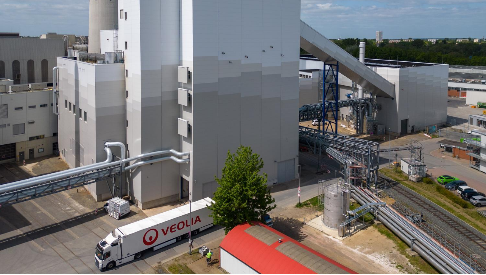
Das Biomasseheizkraftwerk von BS Energy in Braunschweig.
